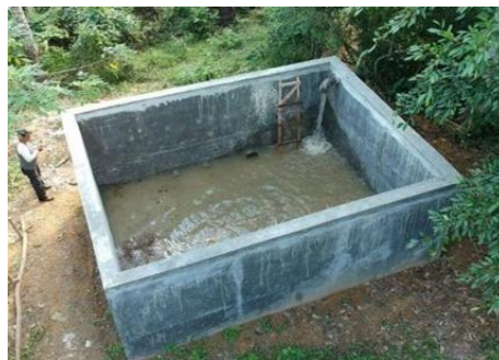
Gambar 2. PAH Beton Cor (Google).
