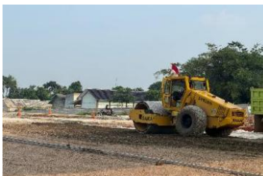
Gambar 6. Pekerjaan Lapis Fondasi
