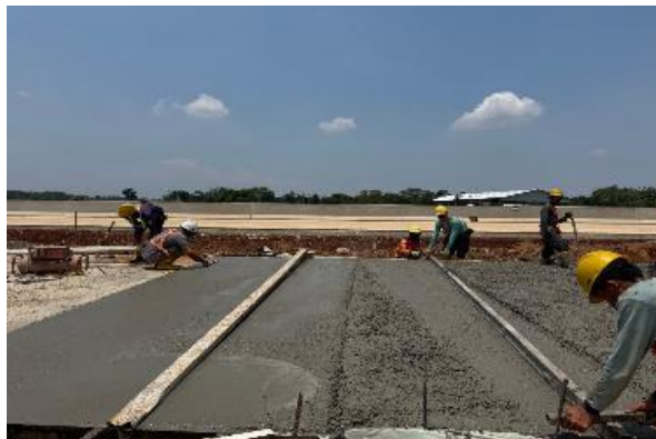
Gambar 8. Pekerjaan Perkerasan Kaku
