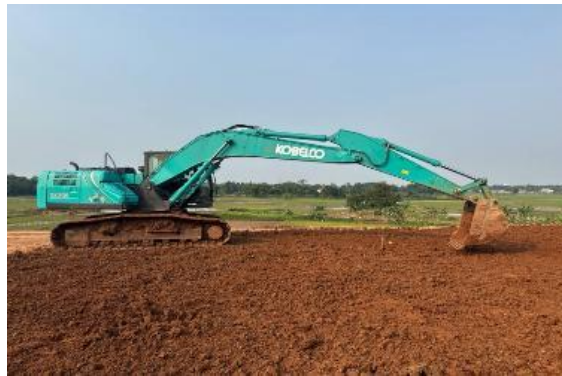
Gambar 5. Pekerjaan Tanah Dasar
