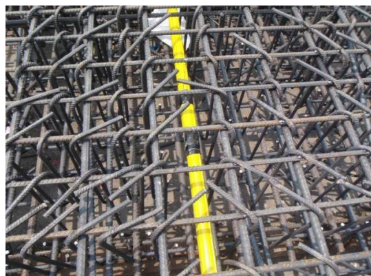
Gambar 6. Pemasangan casing inclinometer pada kerangka baja tulangan
