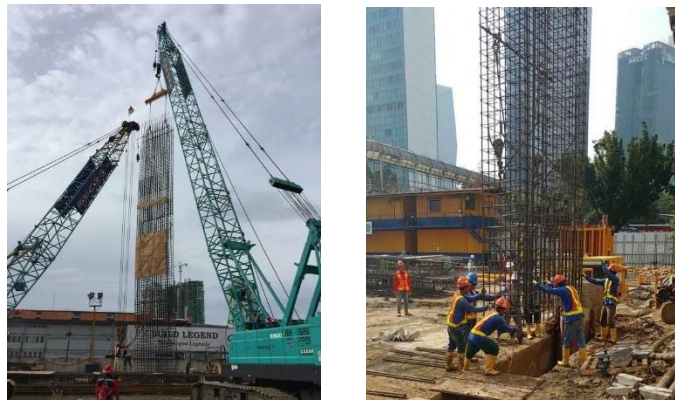
Gambar 17. Pemasangan Kerangka Baja
