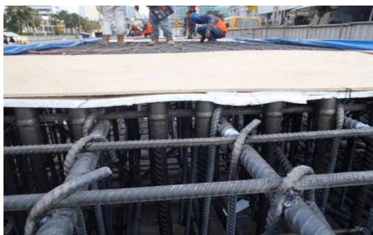
Gambar 4. Pembuatan Tulangan Baja
