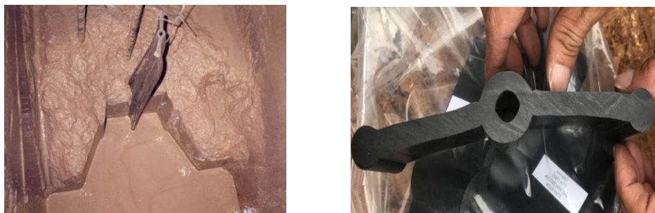
Gambar 15. Sambungan D-Wall
