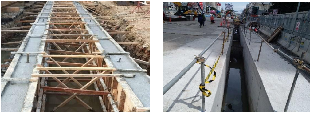
Gambar 3. Konstruksi Dinding Panduan
