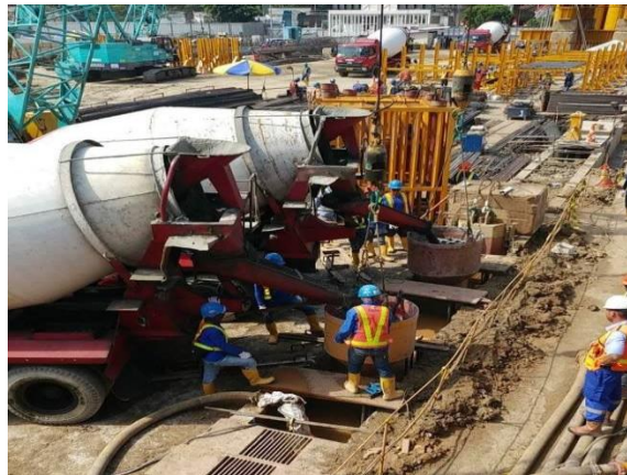
Gambar 20. Proses Pengecoran
