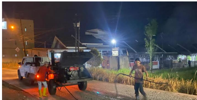
Gambar 4. Penyemprotan Asphalt Sprayer
