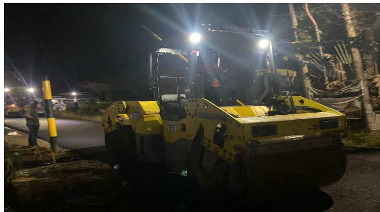
Gambar 6. Pemadatan pertama menggunakan Tandem Roller
