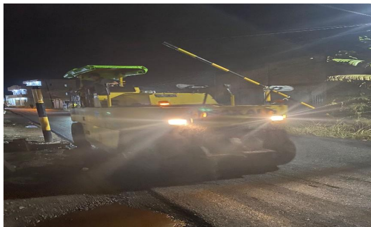
Gambar 7. Pemadatan kedua menggunakan Pneumatic Tyred Roller
